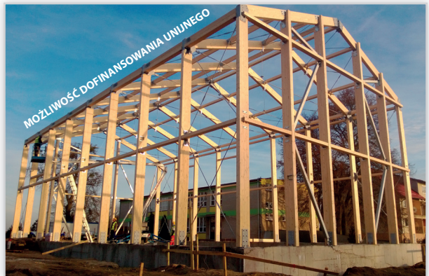
Lilleheden, Sala sportowa, konstrukcja hali typowej – Przechmark
